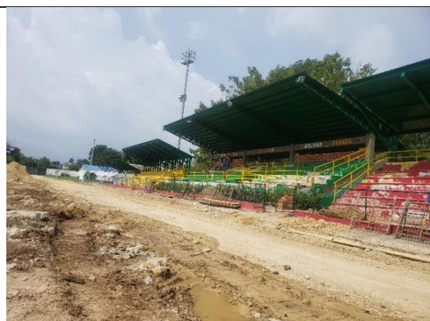
Foto No42. Estado actual de la obra al 29 de agosto de 2019.
