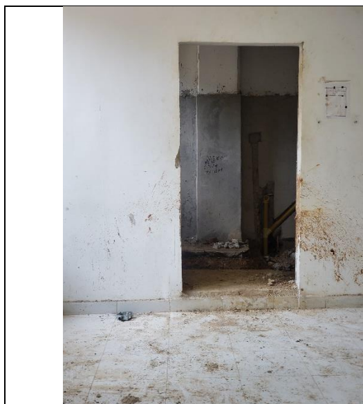
Foto No.21 Acceso a baños PMR, dormitorios
