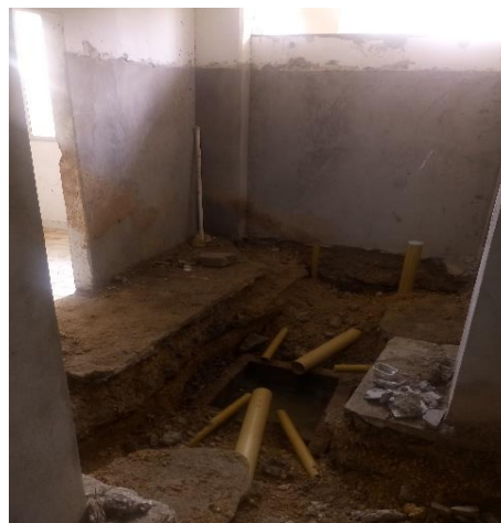
Foto No38. Estado actual de la obra al 29 de agosto de 2019.
