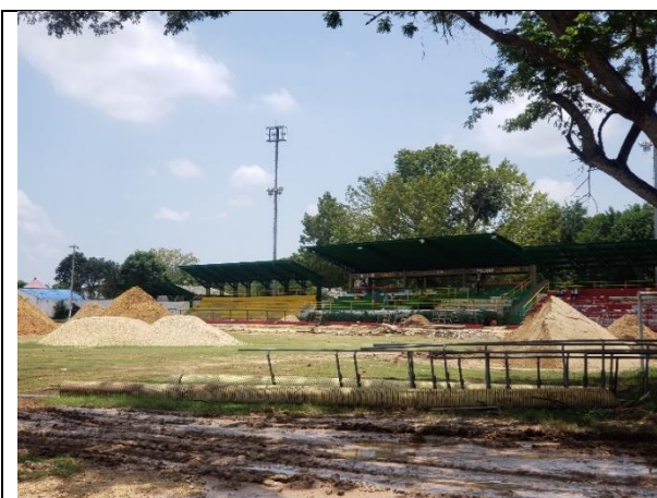
Foto No41. Estado actual de la obra al 29 de agosto de 2019.
