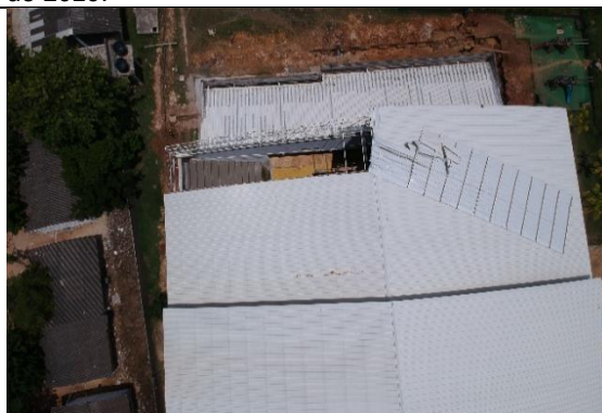
Foto No39. Estado actual de la obra al 29 de agosto de 2019.
