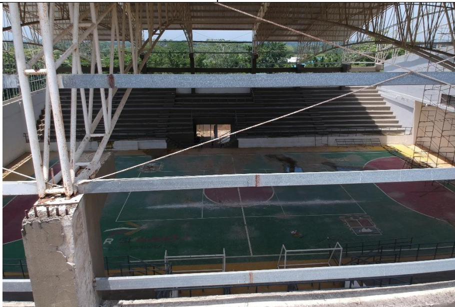
Foto No.34. Estructura en concreto soporte a la estructura metálica de cubierta.
