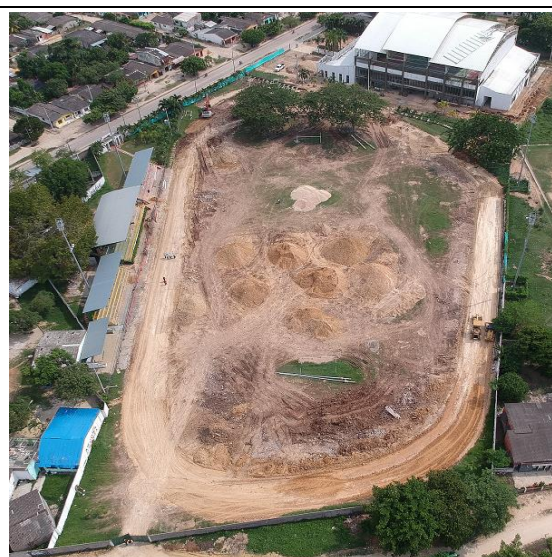
Foto No43. Estado actual de la obra al 29 de agosto de 2019.
