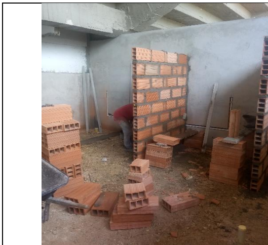
Foto No35. Estado actual de la obra al 29 de agosto de 2019.
