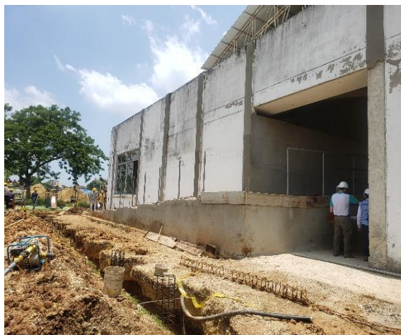
Foto No37. Estado actual de la obra al 29 de agosto de 2019.
