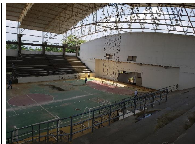
Foto 25. Vista panorámica obras cancha múltiple y graderías.
