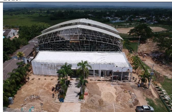
Foto No.40. Estado actual de la obra al 29 de agosto de 2019.
