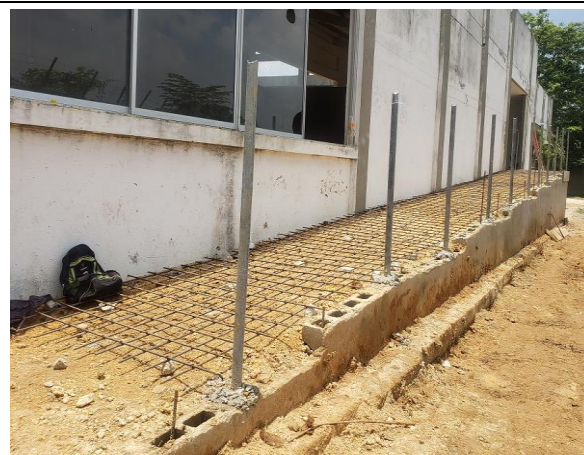
Foto No36. Estado actual de la obra al 29 de agosto de 2019.
