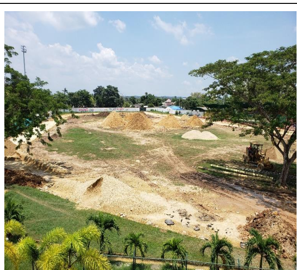
Foto No44. Estado actual de la obra al 29 de agosto de 2019.
