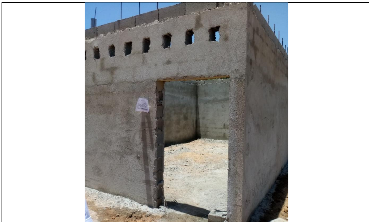
Foto No.13. Ancho de puerta para cuarto de bombas y tanque de almacenamiento, 4000 Lts.
