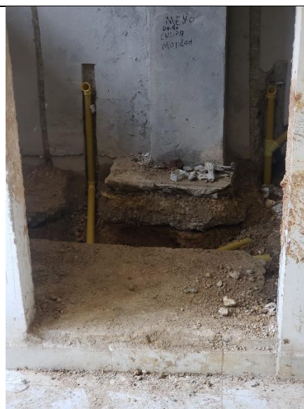
Foto No.22 Acceso a baños PMR, dormitorios
